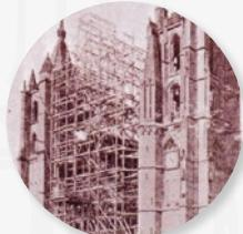
**1966.** Las naves superiores quedan afectadas por un **incendio que forzó la sustitución de las antiguas estructuras de madera** por las actuales de hierro.
